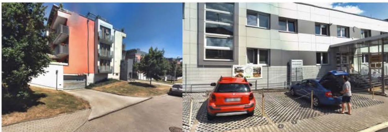
Obr. 9 – Příklad vjezdu do soukromé garáže bytového domu ve Vokovicích a neveřejného parkování u kancelářského objektu na Jarově, zdroj: [10]
