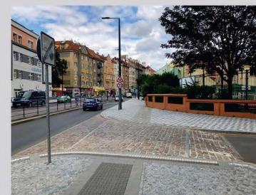
Příklad zachování výškové kontinuity chodníku v místě přecházení přes boční komunikaci.
