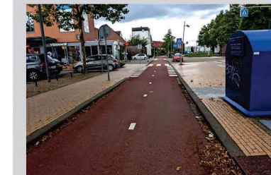
Obousměrný cyklistický pás v přidruženém prostoru (stežka pro cyklisty) výškově oddělený od ploch pro pěší.
