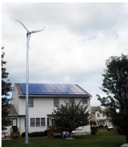
Obrázek 58: V řadě případů VtE přímo na budovách nemá smysl, variantou je menší VtE na stožáru, kombinovaný systém VtE s FVE vč. akumulace. Schéma, vlastní zpracování.
