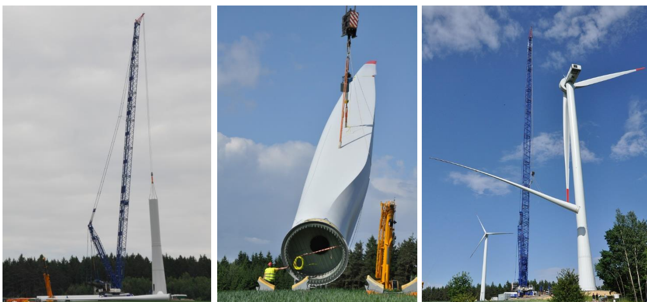
Obrázek 52: Výstavba velké VtE o výkonu 4,2 MW (Gruna - Žipotín, červen 2023), zdroj: vlastní foto
