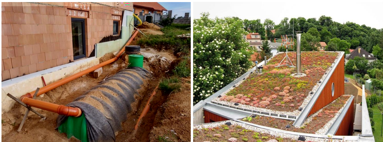
Obrázek 65: Příklady adaptačních opatření vstřícných k přírodě v sídlech, vlevo zachytávání srážkové vody pro její následné využití, vpravo extenzivní zelená střecha. zdroj: Metodika pro hospodaření s dešťovou vodou ve vazbě na zelenou infrastrukturu, ČVUT 2021.
