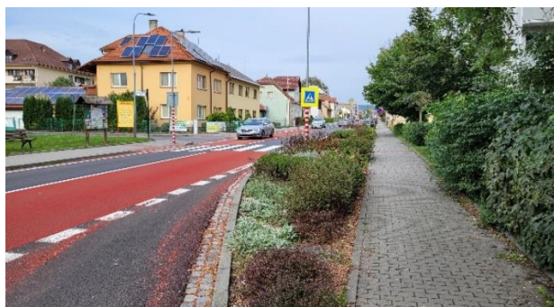
Trvalkové záhony na zbytkových plochách mezi chodníkem a komunikací zvyšují biodiverzitu území i jeho estetickou hodnotu.
