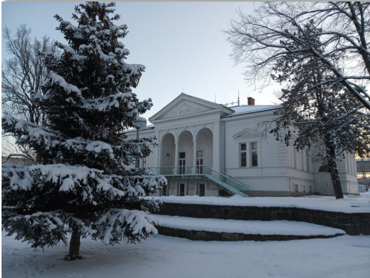
Rekonstrukce Ringhofferovy vily - Stavba MSK roku 2018 – Hlavní cena
