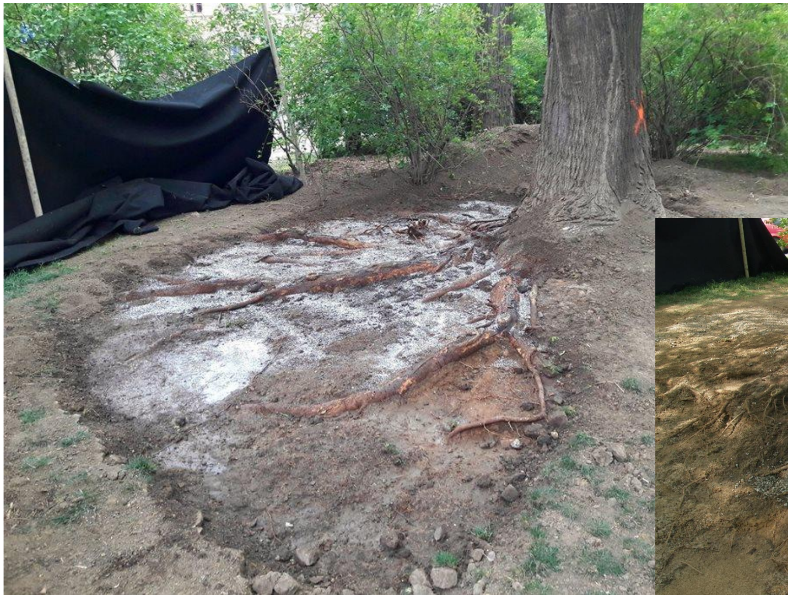
Brno, Moravské náměstí, příprava stromů na revitalizaci , air spade, strukturální substrát, 2020
