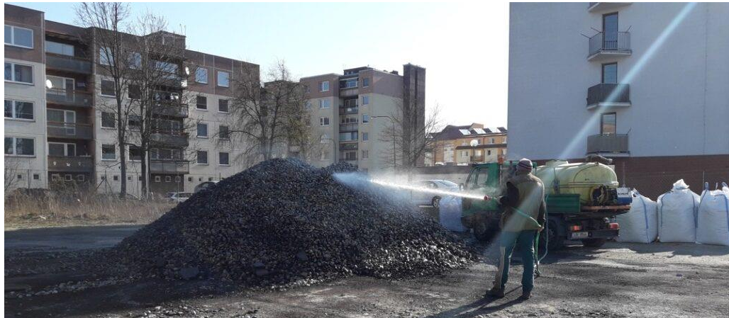
Jihlava- výsadba stromů do strukturního substrátu
